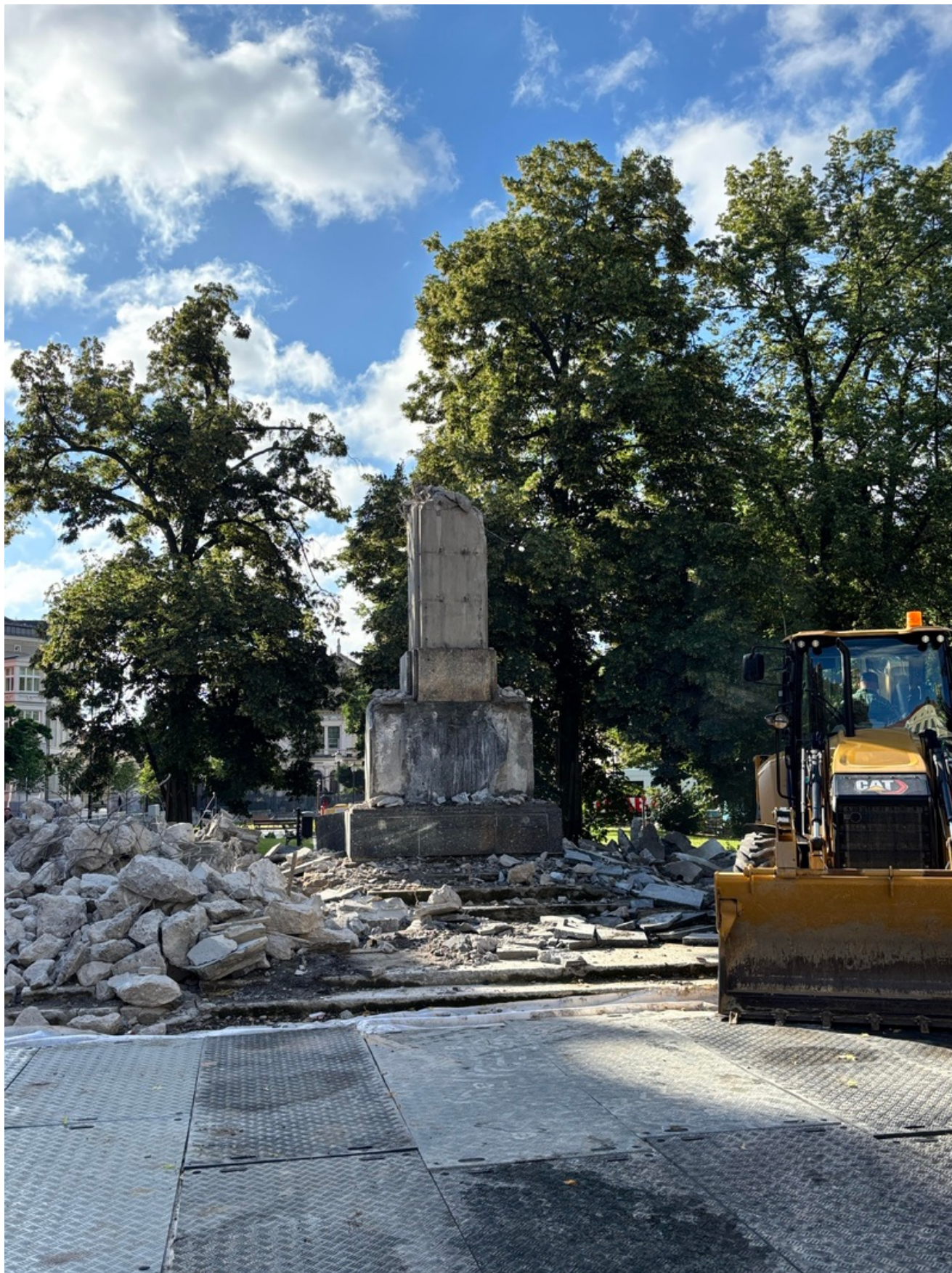
pomnik przy Placu Wolności w trakcie wyburzania; fot. Remigiusz Ławniczak
