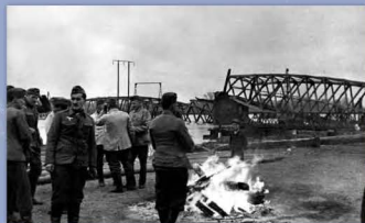
Zniszczony most w Łące
