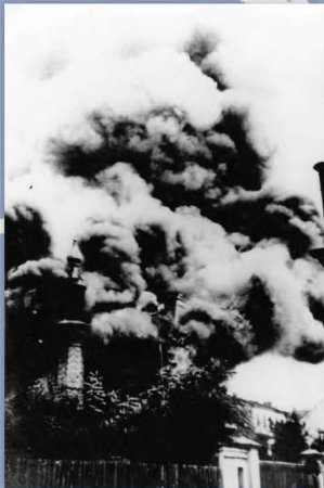
Płonąca synagoga we Włocławku, październik 1939 r.
