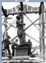
Budowa pomnika Fryderyka Wiślickiego w Bydgoszczy
