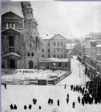
Wyburzenie jezuickiego Kościoła wraz z zachodnią pierzeją Starego Rytku w Bydgoszczy
