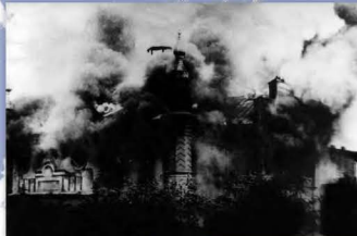
Płonąca Syngnaga w Włocławku, październik 1939 r. Budynek został zbombardowany przez polnię
