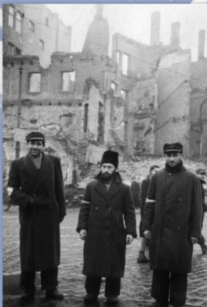
Włocławscy Żydzi na tle spalonej synagogi
