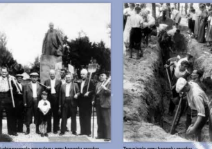
Bydgoszczanie pracujący przy kopaniu rowów przeciwczołwicznych, sierpień 1939 r.
