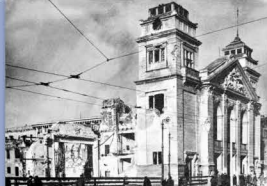
Budynek Bydgoskiego Teatru Miejskiego spalony przez Armię Czerwoną w styczniu 1945 r.
